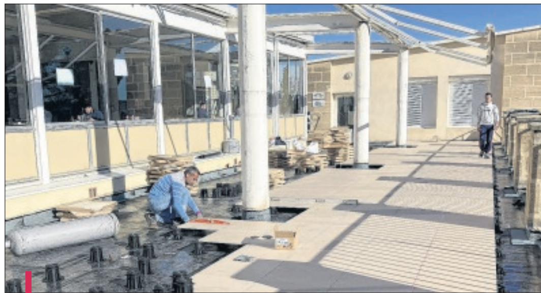
Des travaux ont déjà commencé sur le site hôtelier, où la terrasse est en cours de rénovation. / PHOTO J.C.M.
